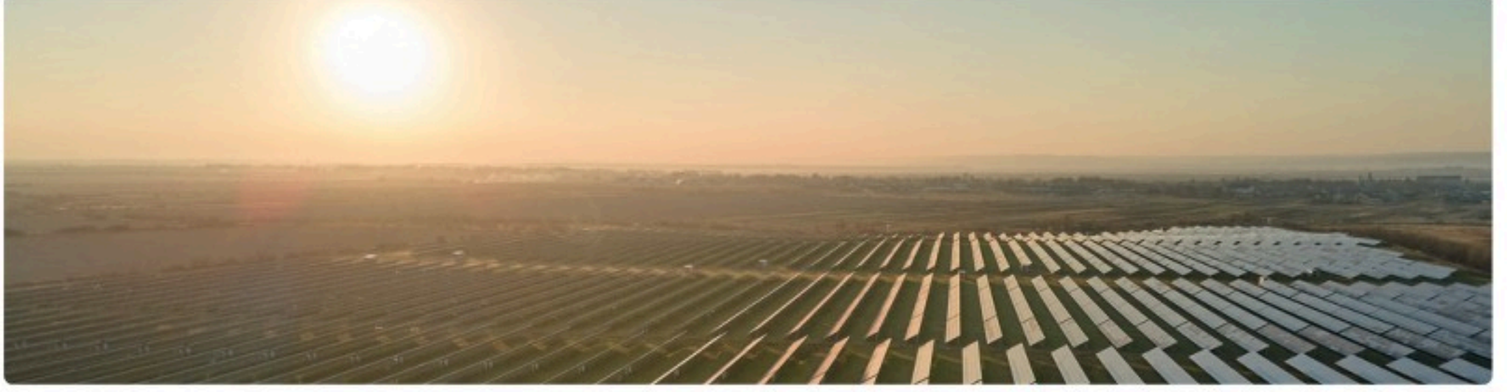
شكل 1.9: الطاقة الكهربائية النظيفة من الألواح الكهروضوئية الشمسية
