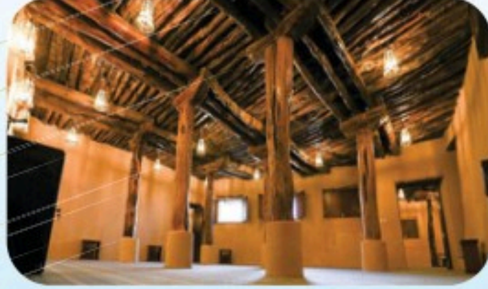
مسجد تاريخي بعد ترميمه
