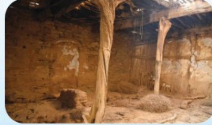
مسجد تاريخي قبل ترميمه
