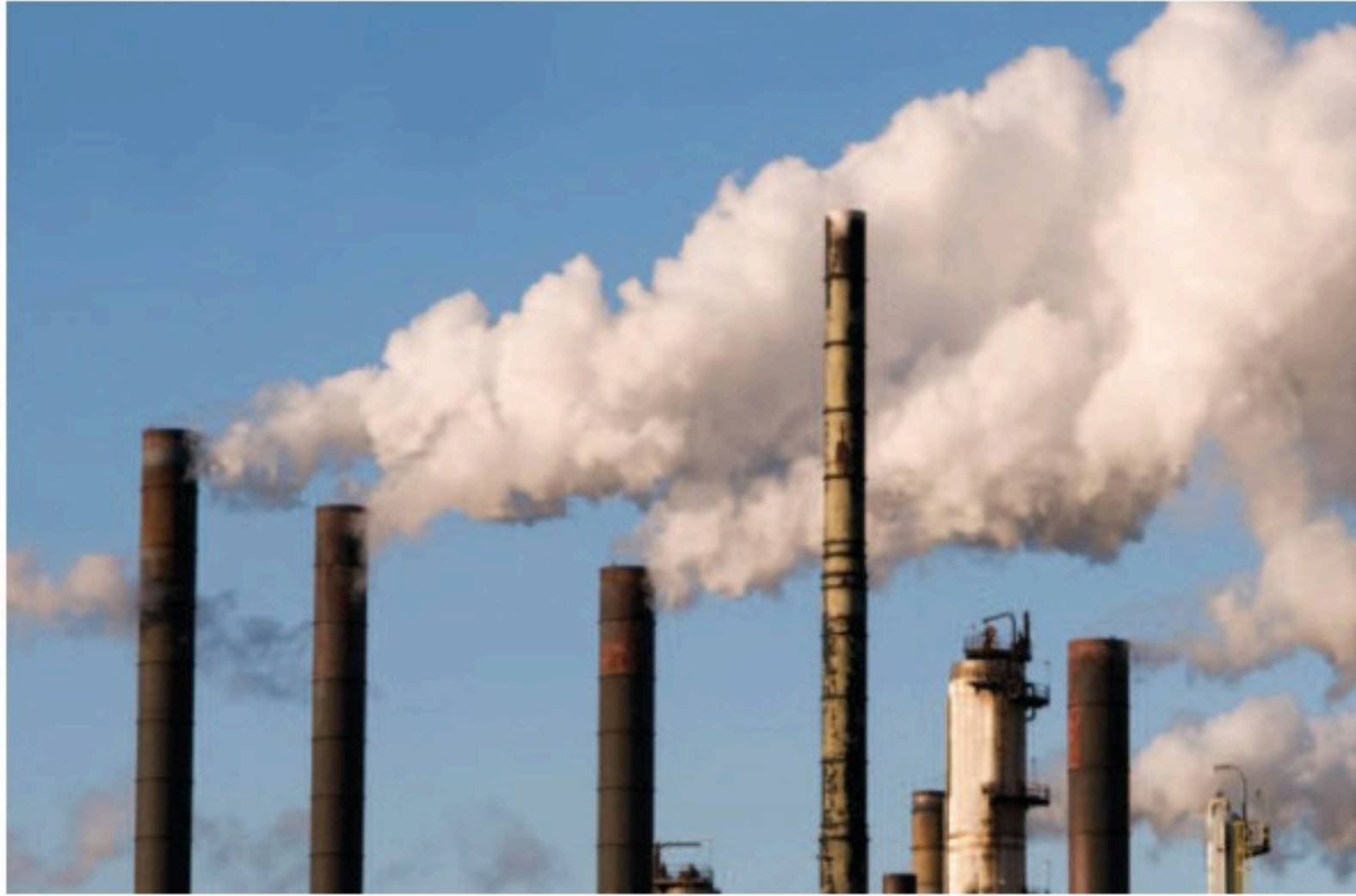
■ الشكل 14-2 الرماد المتصاعد من المداخن نتيجة ثانوية لاحتراق الفحم. ويمكن استعمال مرشحات الترسيب الكهروستاتيكية لتقليل هذا الرماد.
