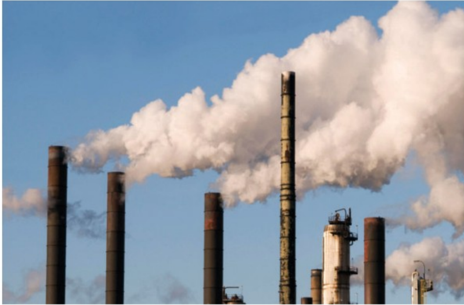
■ الشكل 14-2 الرماد المتصاعد من المداخن نتيجة ثانوية لاحتراق الفحم. ويمكن استعمال مرشحات الترسيب الكهروسكوني لتقليل هذا الرماد.
